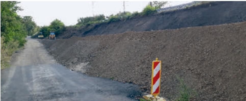
An der Zweenfurther Brücke wurde eine Rampe für die weiterführenden Bauarbeiten aufgeschüttet. (Quelle: DB Netz AG)
