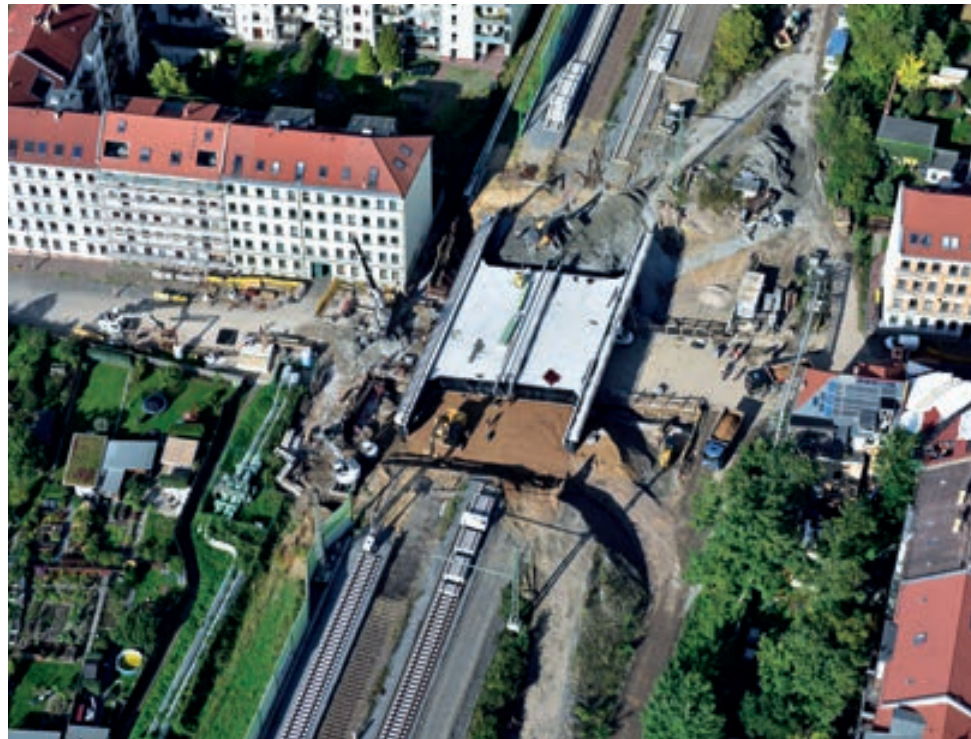
Luftbild Eisenbahnbrücke Zweinaundorfer Straße
