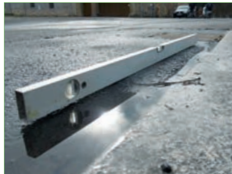
Hinter dem höchsten Punkt befindet sich der Wassereinlauf (Gully) © A. Kalteich
