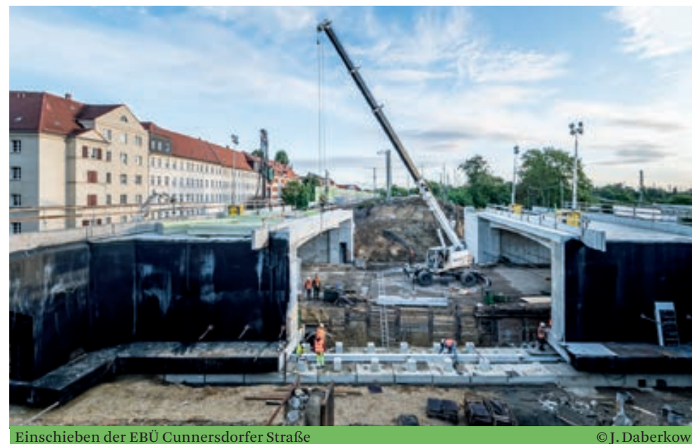
Einschieben der EBÜ Cunnersdorfer Straße
