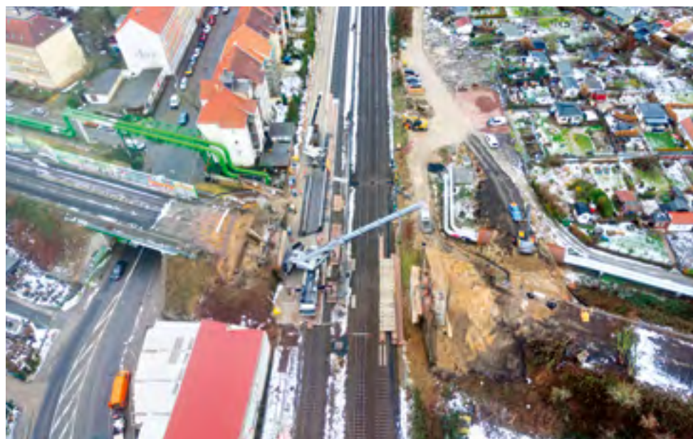
Überblick über die Baustelle und Umgebung
