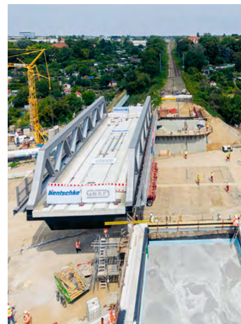
Start des Verschiebens der neuen Brücke
